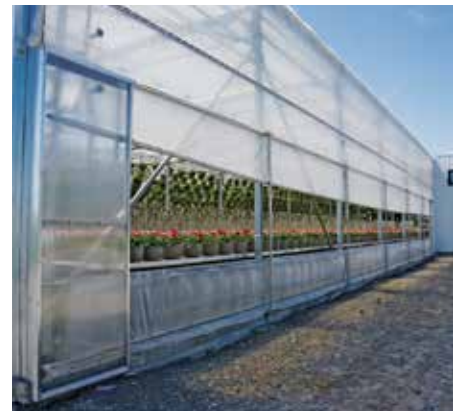
Ventilation enroulable partielle
