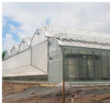
Ventilation mécanisée (cooling pad)
