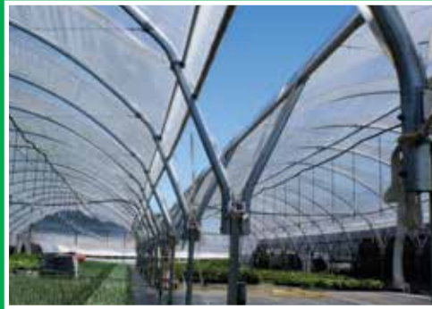
Ouverture par enroulement de 42" de haut jusqu'à 300 pieds (jusqu'à 2 pas baie, une de chaque côté)
