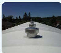
AÉRATEURS DE TOIT
