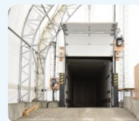
PLATEFORME DE CHARGEMENT
